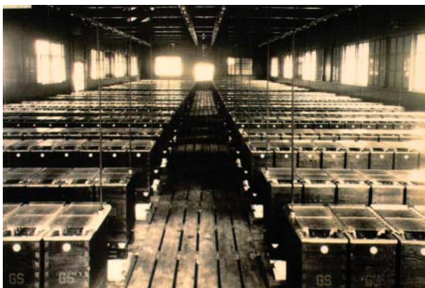
高野山電鉄細川変電所に納入した据置用電池(1930年)
